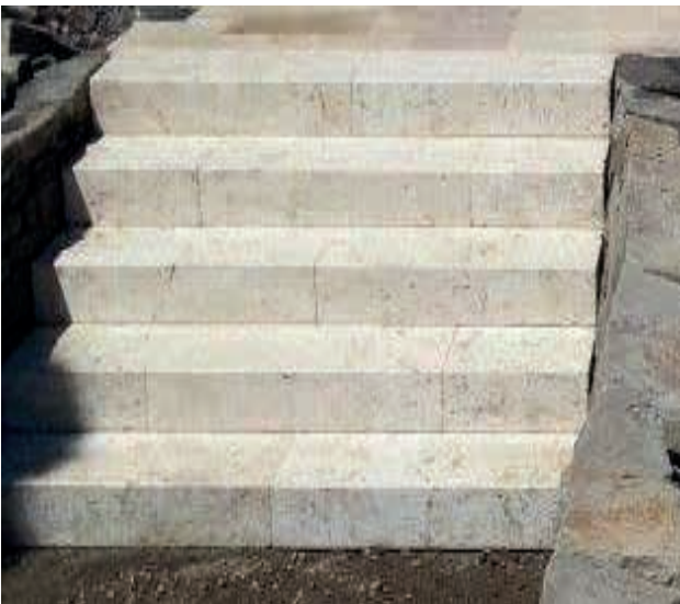
Blockstufen Travertin, geschliffen
